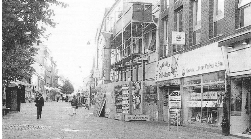
Fig. 1. Skomagergade 19 fotograferet i oktober 1997, da det var gemt bag plankeværk og med forhuset hængt op i jern. I billedets midte skimtes ruden i gadebelægningen, hvor man kan se ned til frådstensvejen, der udgravedes i 1993. Foto Hanne Dablerup Koch.
