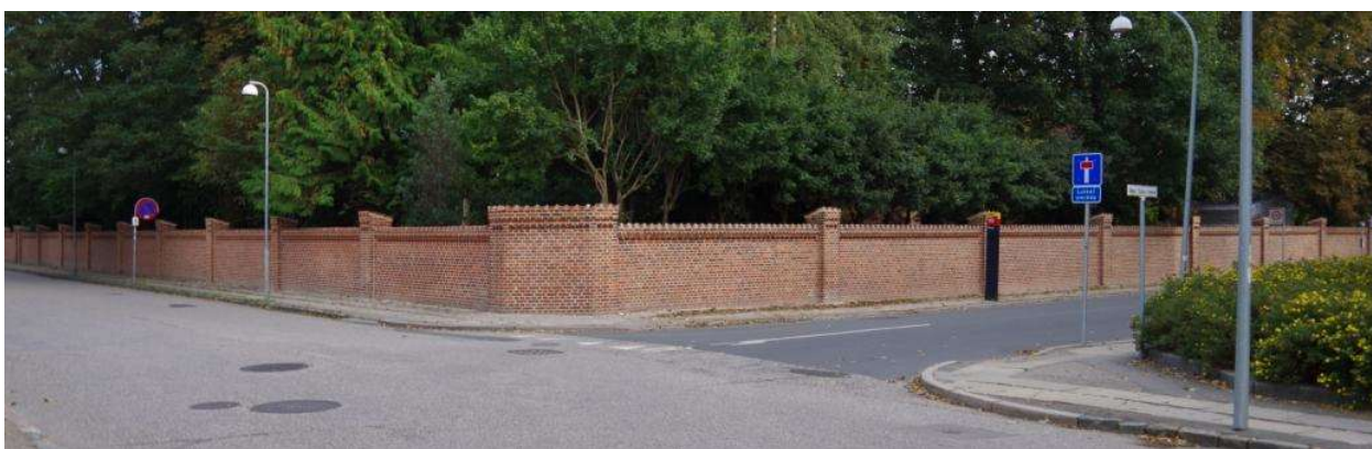
Den 235 meter lange klostermur blev totalrenoveret i 2013
