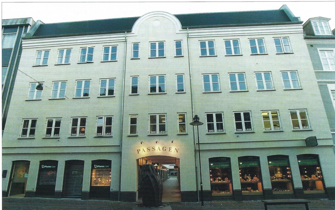
Skomagergade 15 - efter ombygning
