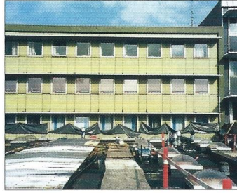
Skomagergade 15- før ombygning
